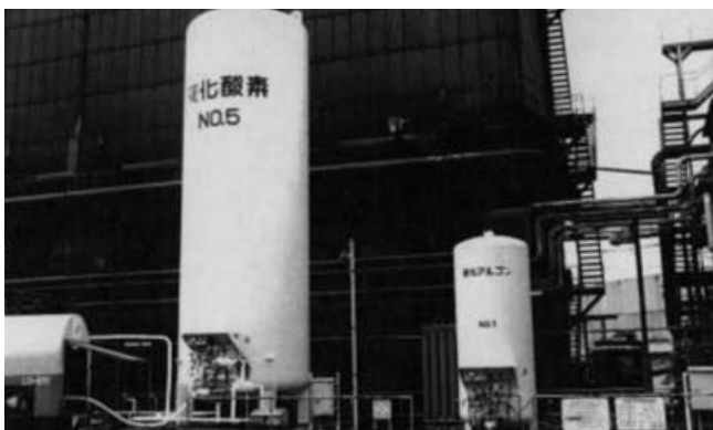
写真3 施工物件(ガスホルダー)
