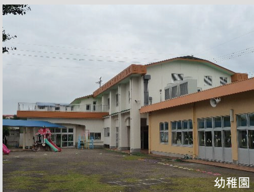
写真3 アロンウオールNEOの施工事例
