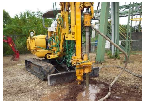
写真 2 削孔状況
