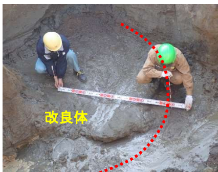
写真 3 改良体の出来形測定例
