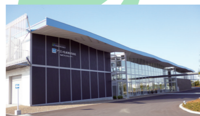
Monozukuri Center, Aronkasei Co., Ltd.
