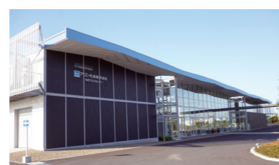
Monozukuri Center, Aronkasei Co., Ltd.
