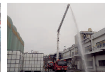
屈折放水塔車による放水(川崎工場)
