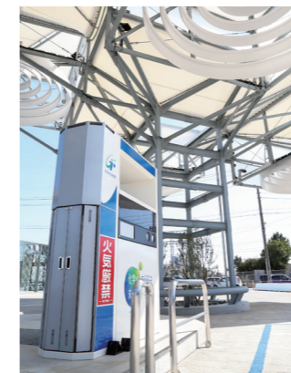
高圧水素ガスディスペンサー
