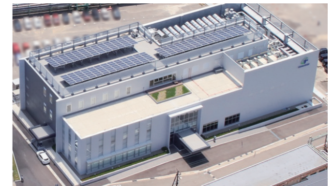
屋上の太陽光発電システム(高岡創造ラボ)
