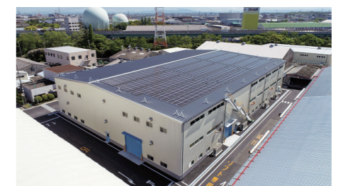
名古屋工場 射出第2工場(竣工:2021年3月)
