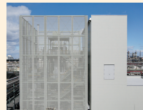
名古屋工場フレークカセイカリ設備
