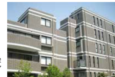
透明な塗膜でタイル外壁の風合いを生かす「クリアウオール®」施工例
