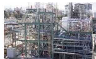
MTエチレンカーボネートに 新設されたEC製造プラント
