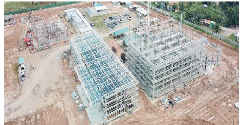
急ピッチで建設が進む タイ新工場
