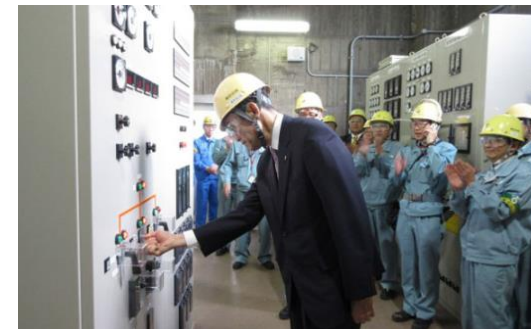
17年11月 新設備 通電の様子
