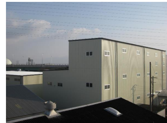
アロン化成名古屋工場 新製造建屋
