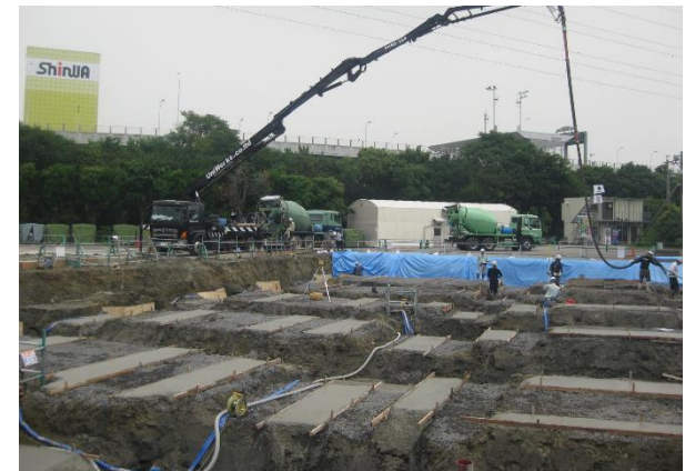
アロン化成 名古屋工場 射出成形設備-配合棟の新設
