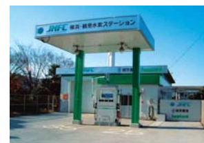
水素ステーション
