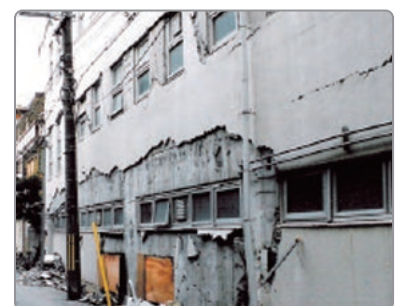
一般的な外壁の状況
