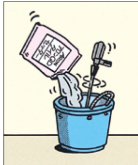
攪拌しながら アロンQDタイトルセッター 20kg逐次投入
