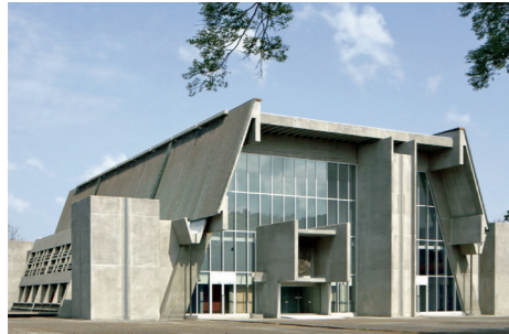
クリア工法 (改修)
