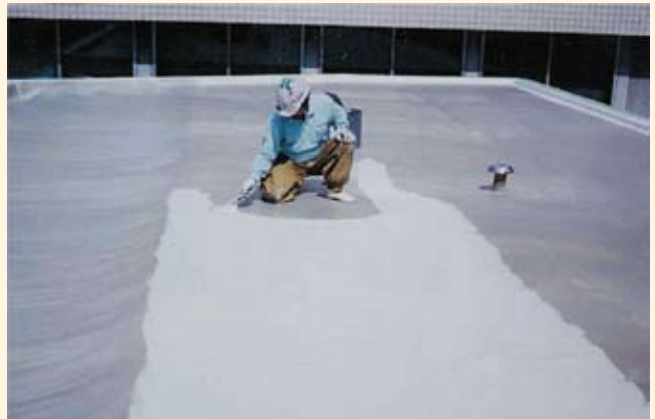
左官刷毛での施工(2回塗り)
