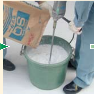
攪拌しながらSQセッター1袋(10kg)を逐次投入する。粘度を調整し、2~3分間十分に混合する。
