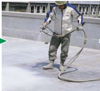
3 防水材吹付け(1回塗り)
