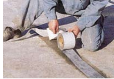
アロンゴムシートテープの張付け
