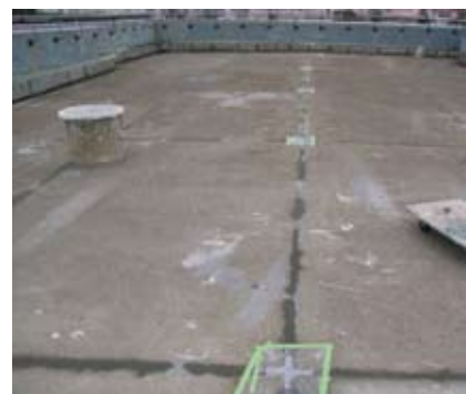
目地処理の施工例
