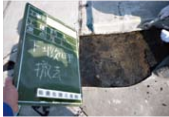
下地処理(ふくれ部撤去)
