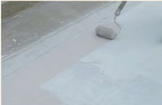
ローラーでの施工(2~3回塗り)
