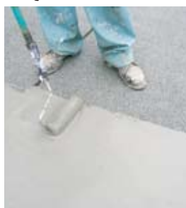
アロン水性プライマー塗布後 アロンコートSQ-M用調整材を塗布
