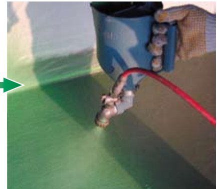
4 仕上塗料吹付け
