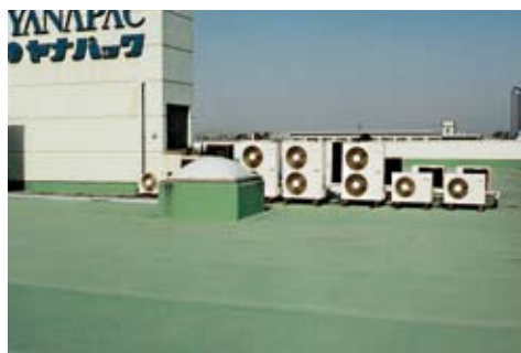
SQ-S 施工後、16年経過後の状況
