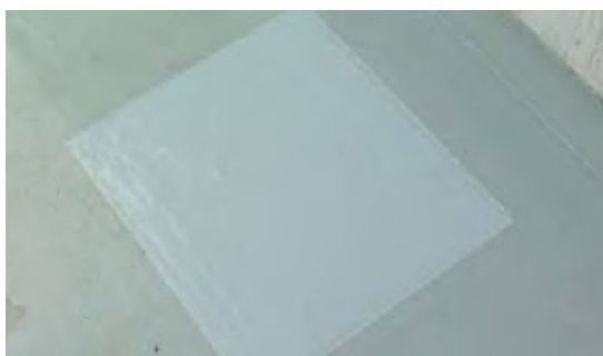
SQ-S 部分補修の状況
