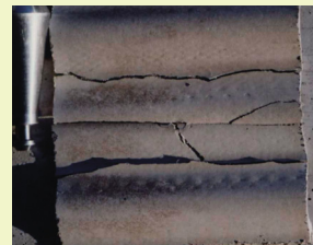
未施工スレート板
