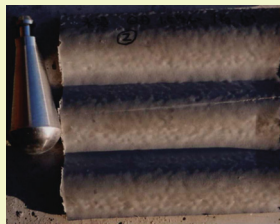
アロンQDスレート施工
