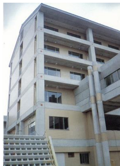
施工例(RC打放し部)
