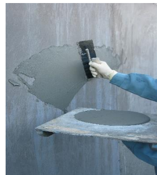
施工状況(コテ塗り)
