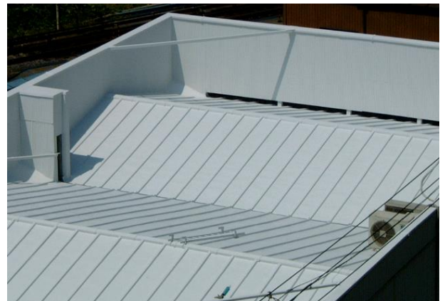
施工例(瓦棒屋根)
