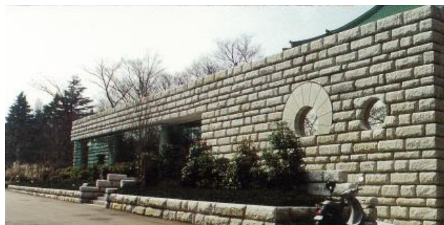
施工例(RC打放し部)
