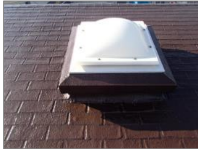
SQ-AS工法施工例 (既存:アスファルトシングル葺き屋根)
