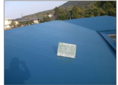
SQ-K工法施工例 (既存:アスファルトシングル葺き屋根撤去)
