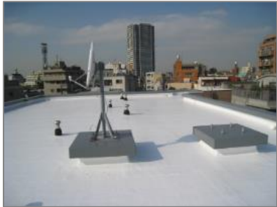
SQ-M工法施工例(既存:露出アスファルト防水)
