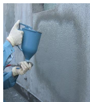
施工状況(吹付け)
