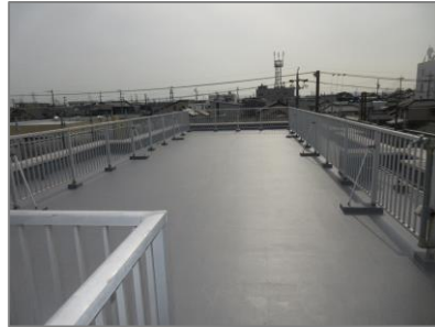
SQ-S工法施工例(既存:ウレタン防水)
