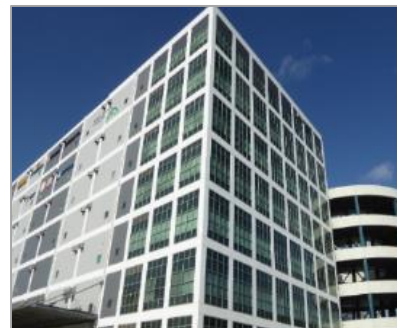
NEO工法 (大型倉庫)
