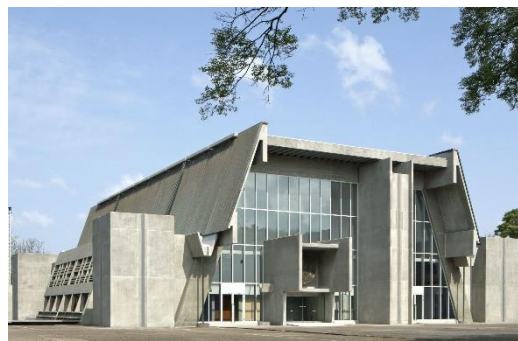
施工例(クリヤ工法)
