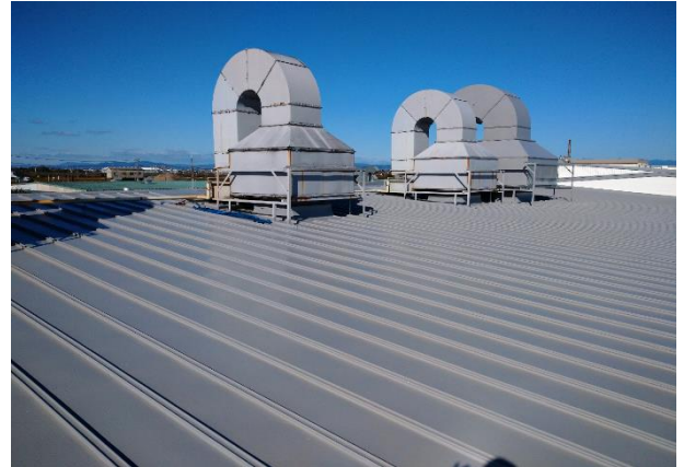
施工例(折板屋根)
