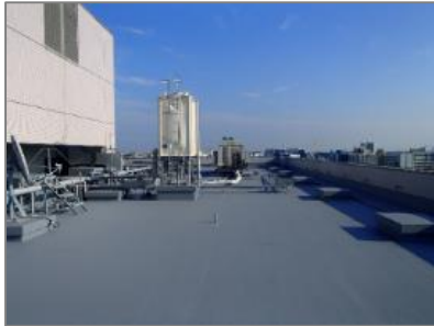
SQ-KS工法施工例(既存:保護アスファルト防水)
