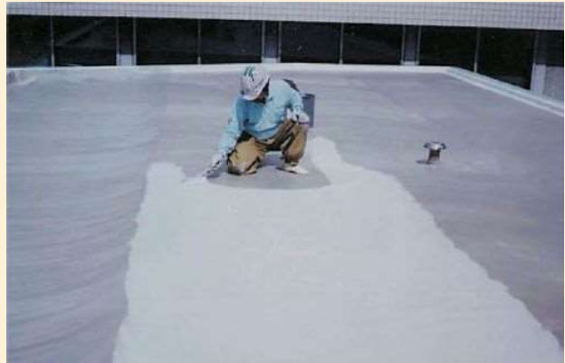
左官刷毛での施工(2回塗り)
