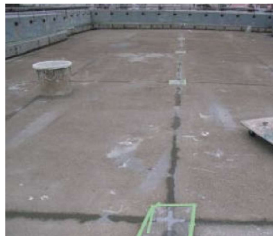
目地処理の施工例
