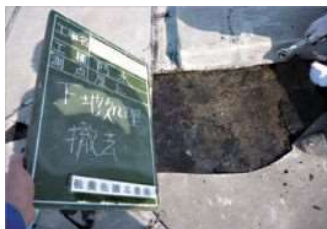
下地処理(ふくれ部撤去)
