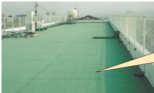
SQ-S工法(防滑仕上) 施工後、10年経過後の状況
