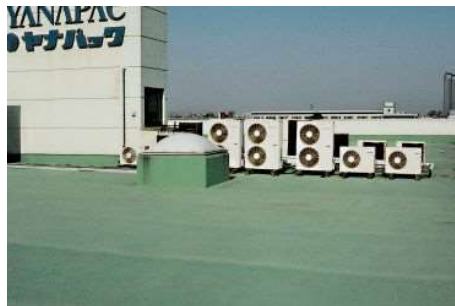
SQ-S 施工後、16年経過後の状況
