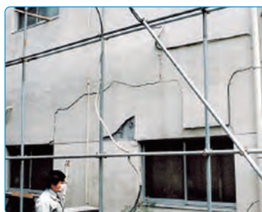
アロンウオール塗布外壁の状況
