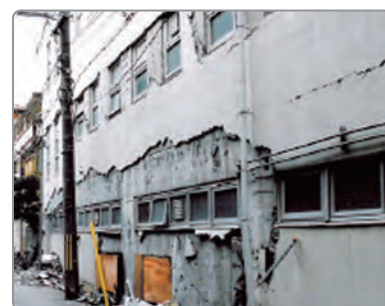
一般的な外壁の状況
