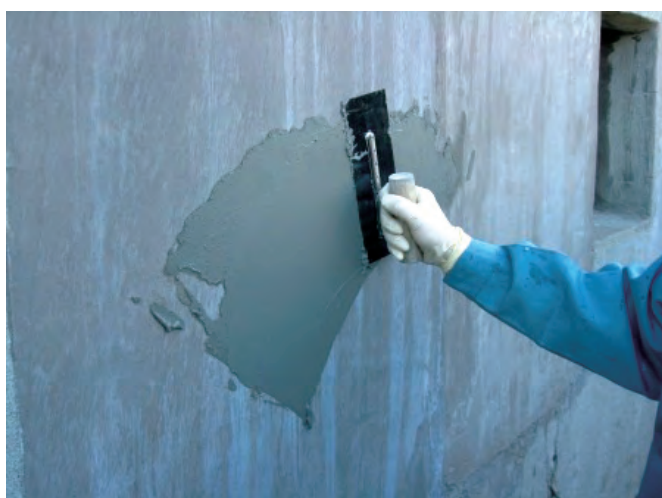
不陸調整作業(アロンカチオクリート)
