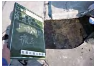
下地処理(ふくれ部撤去)
