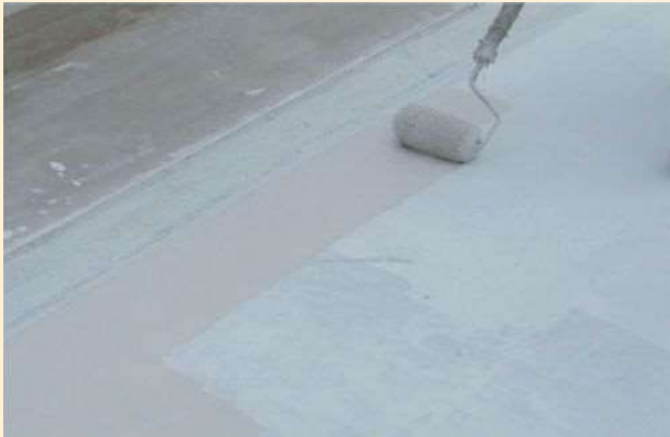
ローラーでの施工(2~3回塗り)
