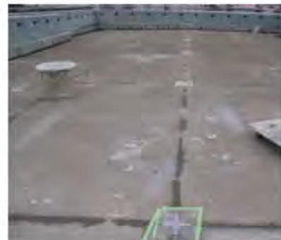
目地処理の施工例
