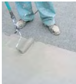
アロン水性プライマー塗布後 アロンコートSQ-M用調整材を塗布
