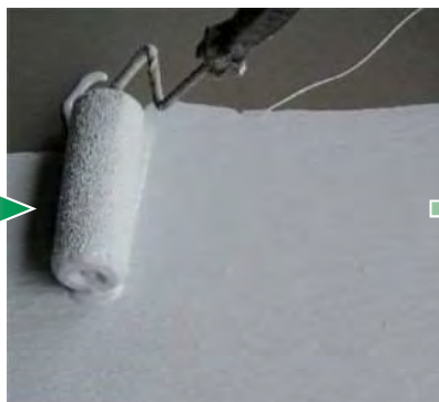
4 防水材塗布(2~3回塗り)
