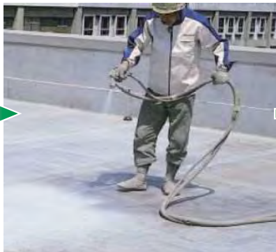
3 防水材吹付け(1回塗り)
