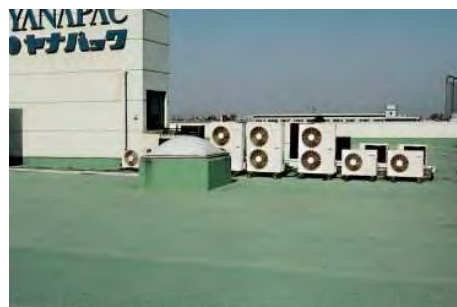
SQ-S 施工後、16年経過後の状況
