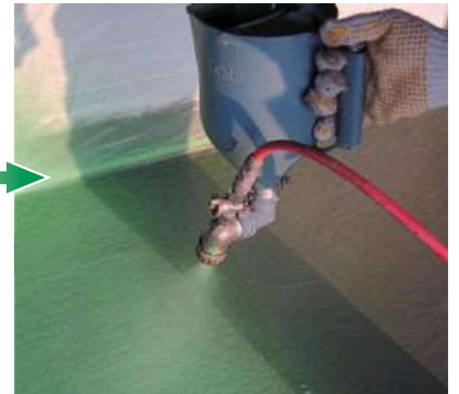
4 仕上塗料吹付け
