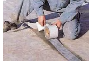
アロンゴムシートテープの張付け
