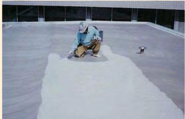
左官刷毛での施工(2回塗り)
